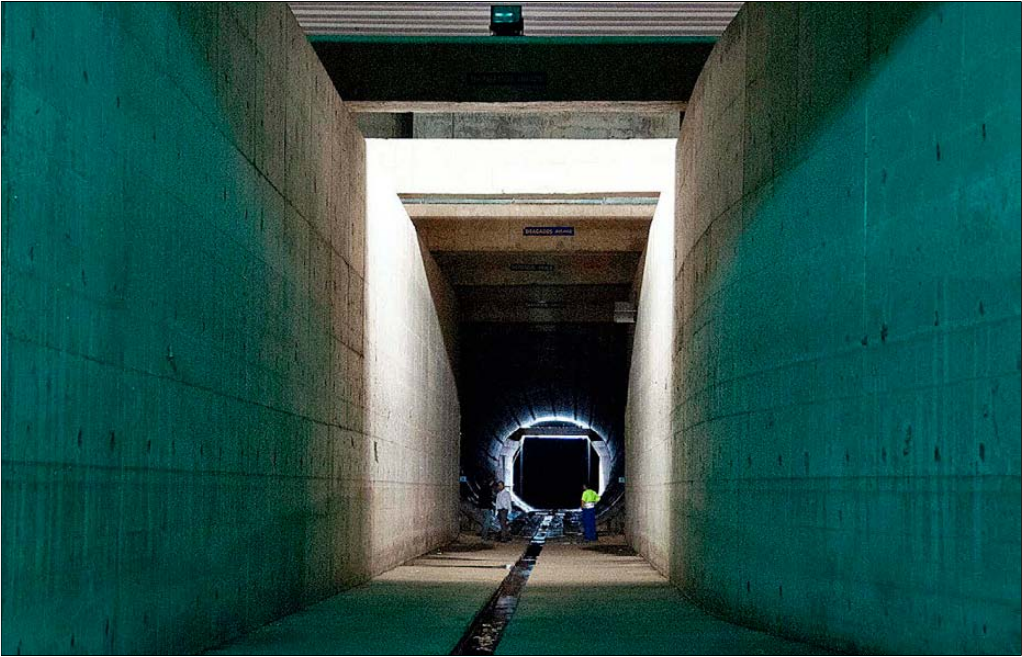
Uno de los tanques de tormentas de Madrid en mantenimiento. E. M.
