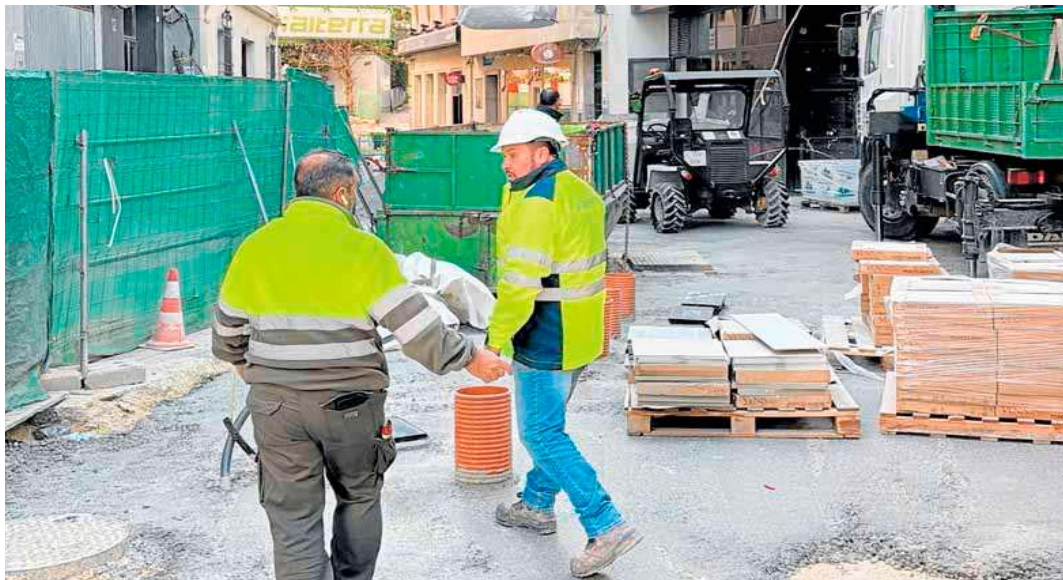
Operarios en los últimos días continúan con las obras de la calle San Clemente. IDEAL
